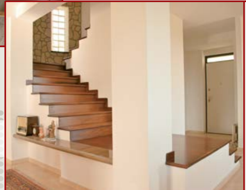
Rivestimento scala in legno Afrormosia alzata chiusa.
